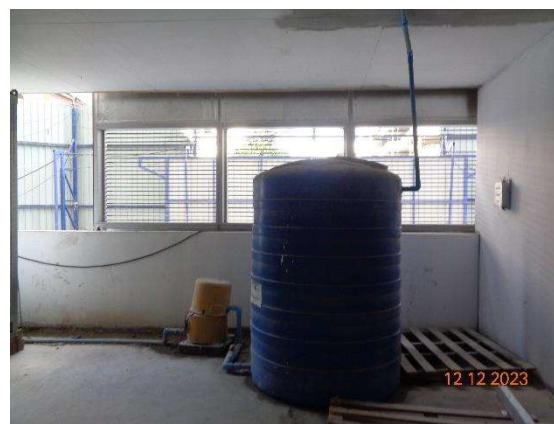
รูปที่ 1-4 ถังน้ำสำรองภายในพื้นที่โครงการ
